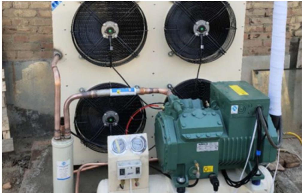
单级蒸汽压缩制冷系统，是由制冷压缩机、冷凝器、节流阀和蒸发器四个基本部件组成。它们之间用管道依次连接，形成一个密闭的系统，制冷剂在系统中不断地循环流动，发生状态变化，与外界进行热量交换。液体制冷剂在蒸发器中吸收被冷却的物体热量之后，汽化成低温低压的蒸汽、被压缩机吸入、压缩成高压高温的蒸汽后排入冷凝器、在冷凝器中向冷却介质(水或空气)放热，冷凝为高压液体、经节流阀节流为低压低温的制冷剂、再次进入蒸发器吸热汽化，达到循环制冷的目的。这样，制冷剂在系统中经过压缩、冷凝、节流、蒸发四个基本过程完成一个制冷循环。[6]在制冷系统中，蒸发器、冷凝器、压缩机和节流阀是制冷系统中必不可少的四大件，这当中蒸发器是输送冷量的设备。制冷剂在其中吸收被冷却物体的热量实现制冷。压缩机是心脏，起着吸入、压缩、输送制冷剂蒸汽的作用。冷凝器是放出热量的设备，将蒸发器中吸收的热量连同压缩机做功所转化的热量一起传递给冷却介质带走。节流阀对制冷剂起节流降压作用、同时控制和调节流入蒸发器中制冷剂液体的数量，并将系统分为高压侧和低压侧两大部分。实际制冷系统中，除上述四大件之外，常常有一些辅助设备。
